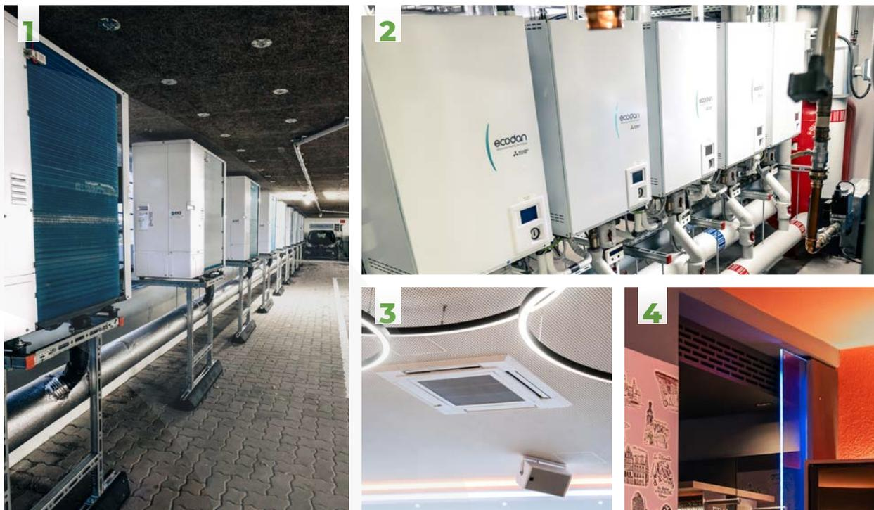
**LINKS** | Hotelturm mit 7 VRF-Wärmepumpen **1** | 10 Außeneinheiten in der Parkgarage
