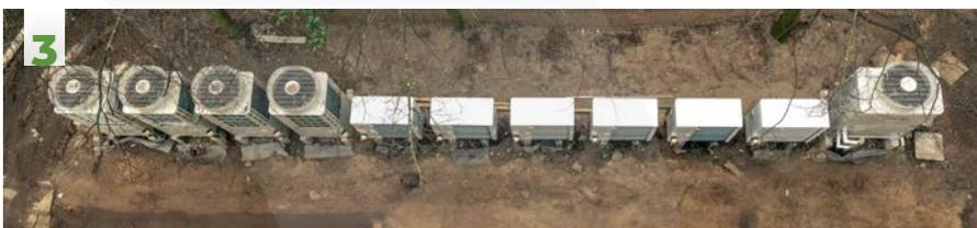
1 | Inneneinheiten 2 | Außeneinheiten 3 | (v. l. n. r.) 4 VRF-Wärmepumpen, 6 Luft-Wasser-Wärmepumpen, 1 CO<sub>2</sub>-Wärmepumpe 4 | Deckenkassette 5 | Wandgerät
